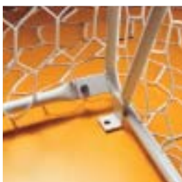
Particolare ancoraggio a terra
